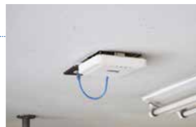
各教室の天井にAP(アクセスポイント)を2基設置
